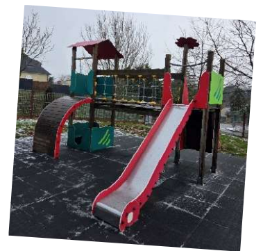
Réparation de la structure
