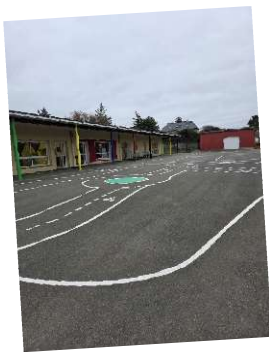
Réfection des tracés sur la cour
